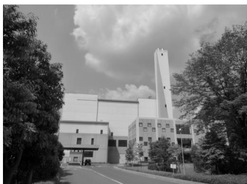
ごみ処理施設「栃木クリーンプラザ」
