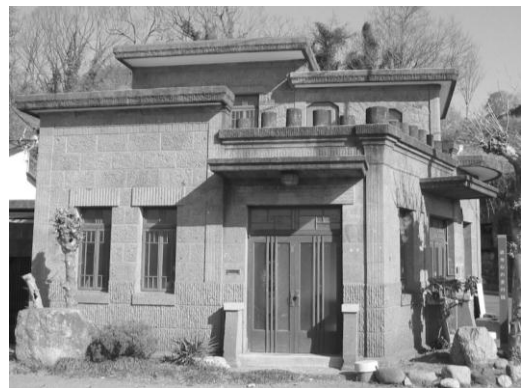
資料館の建物自体が、岩舟石の細工技術の貴重な資料でもあります。
