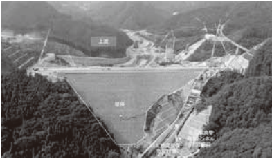
水不足が懸念される南摩ダム
