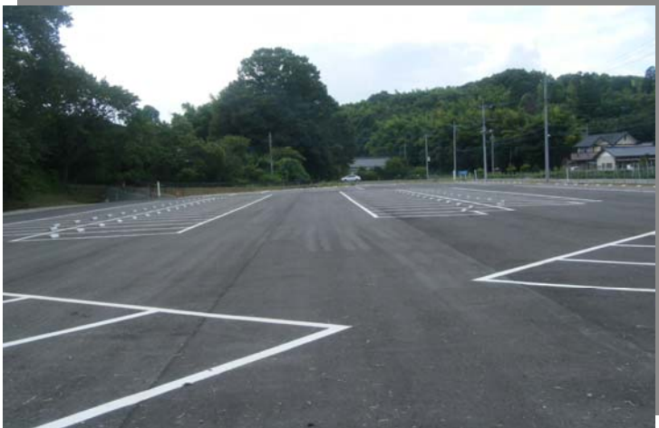
つがの里駐車場整備
