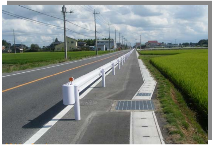
国府町市道113号線交通安全施設整備
