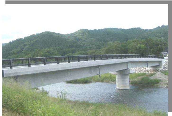
大久保町市道242号線（和田橋）橋りょう整備
