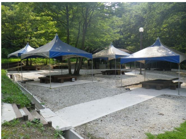
つがの里バーベキュー場整備
