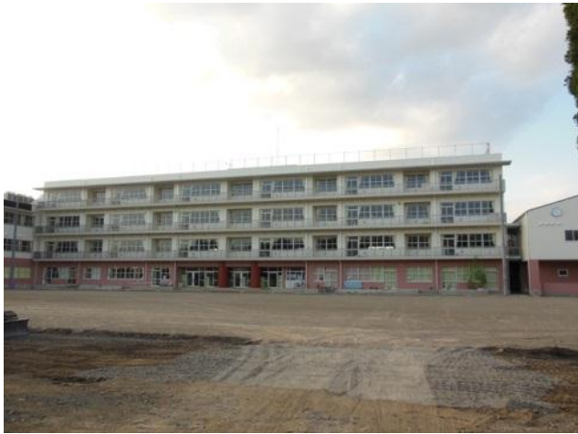
栃木中央小学校新築
