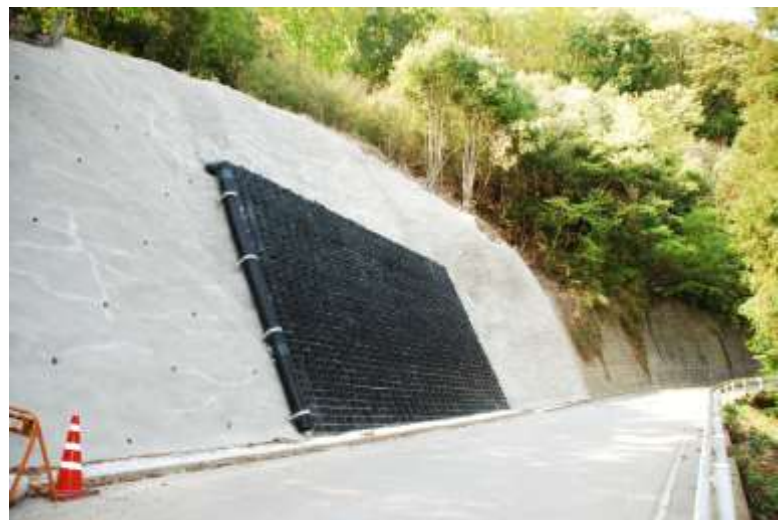
市道 N1009 号線法面補修工事
