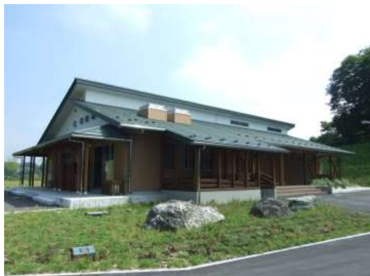
つがの里に建設された 体験交流館
