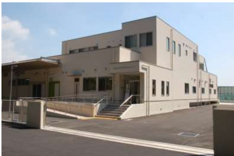
大平学校給食センター竣工
