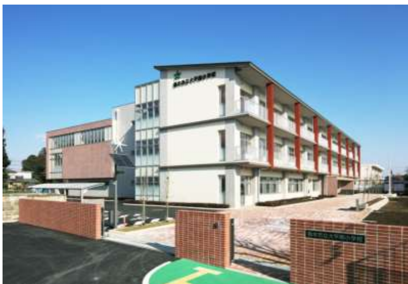
大平南小学校校舎竣工
