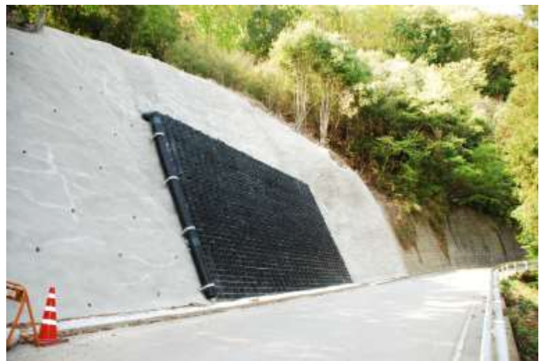
市道 N1009 号線法面補修工事
