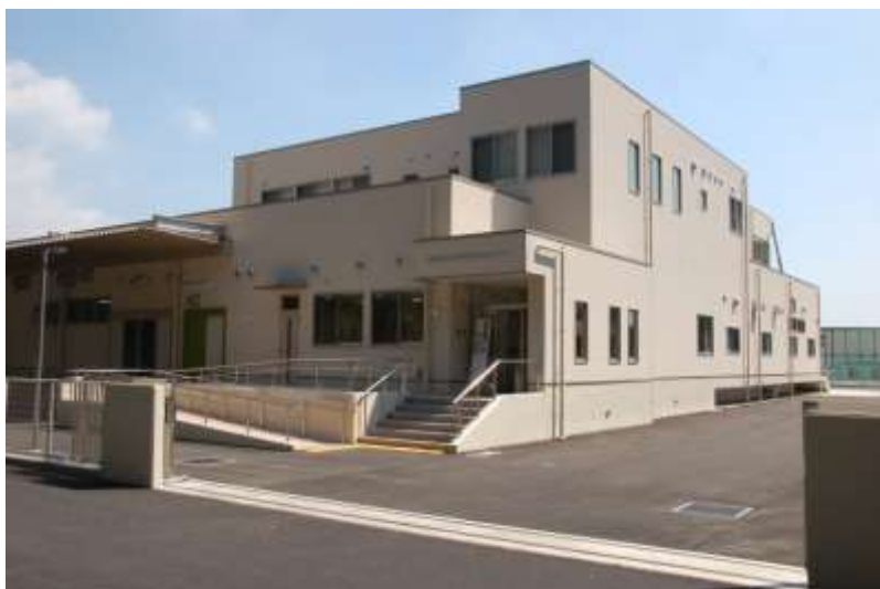
大平学校給食センター竣工
