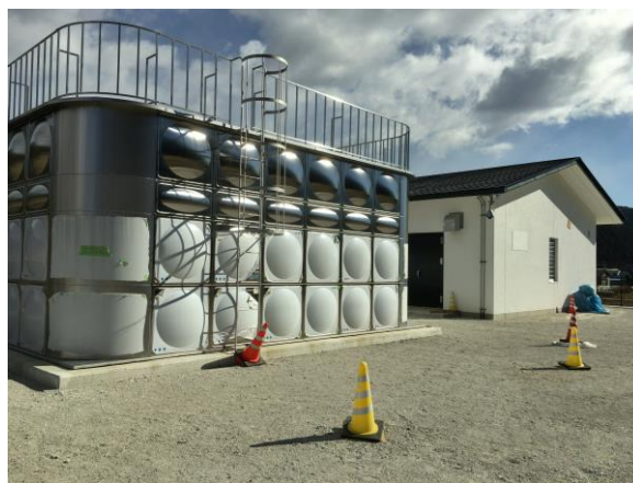
※現在、竣工に向けて建設中の星野浄水場
