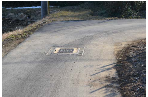
㊫ 消火栓の約1 m先から民家の敷地
