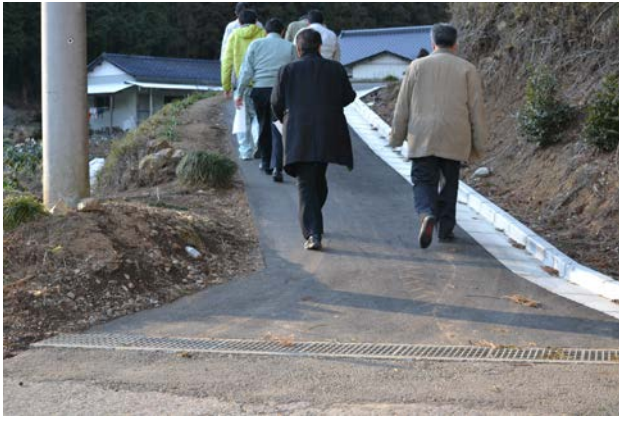
㊦ 町道との接続部分から
