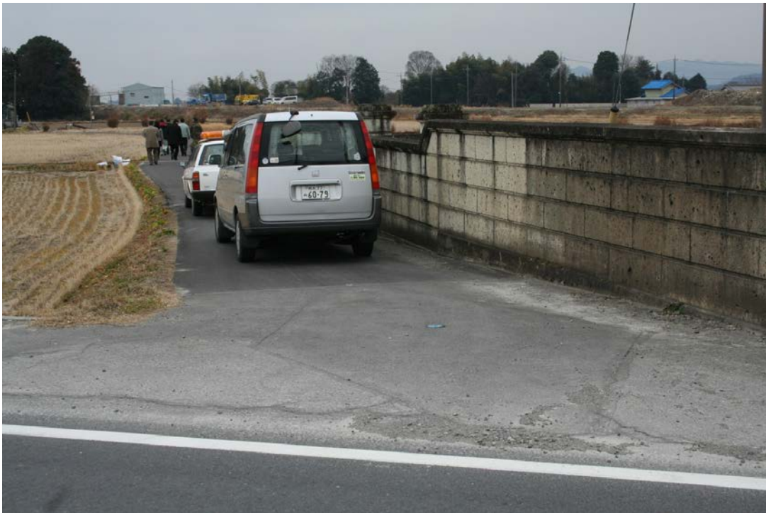
㊦ 町道との接続部分から
