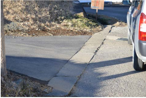
㊦ 町道との接続部分
