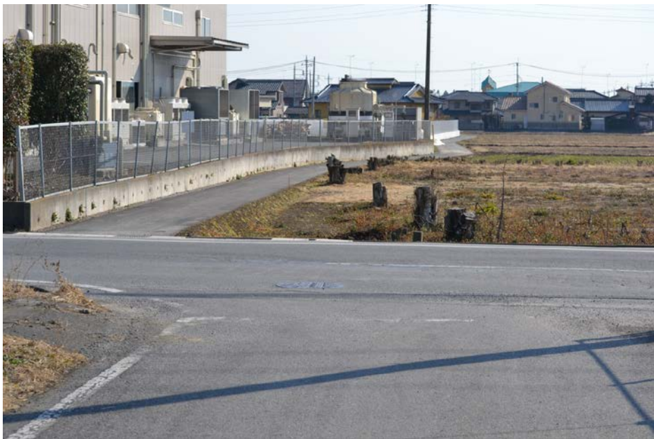
⑦ 町道1005号側から
