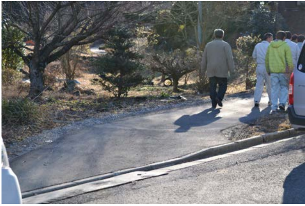
㊦ 町道との接続部分
