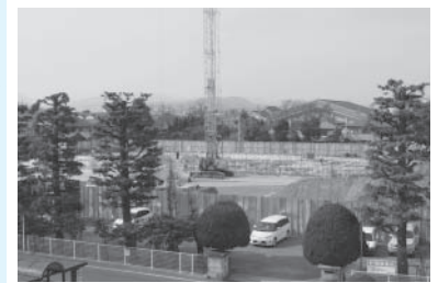
工事中の中央小学校
