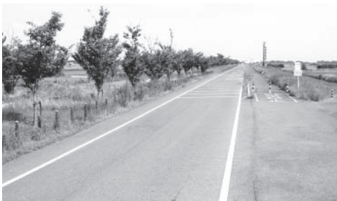
堤防強化の終了した箇所（部屋南部地区）
