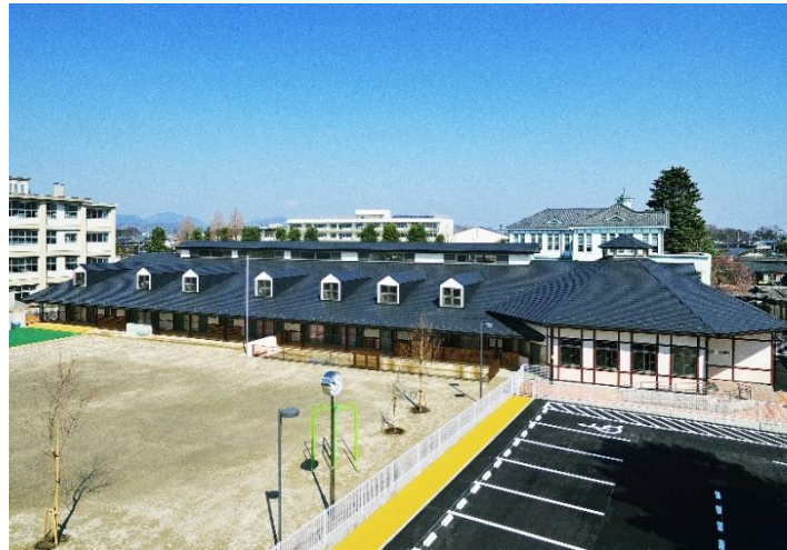
くらのまち保育園 竣工
