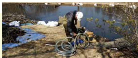
▲水圧をかけ、ハスの根をひとつひとつ掘り出します
