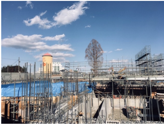
工事現場から温泉タワー、シンボルツリーを見る
