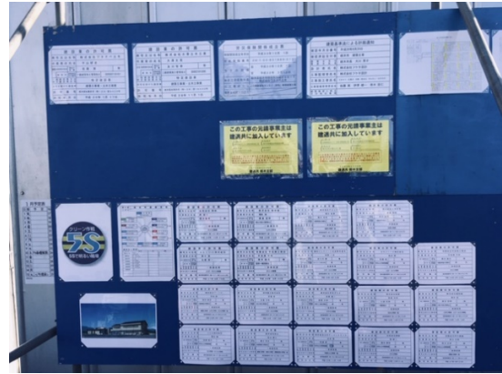
現場仮囲いの掲示状況
