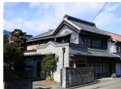
〔修理後の建造物〕
