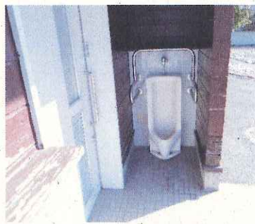
多機能トイレの開放(H25年度) 手すりの設置(H27年度)
