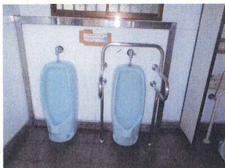
トイレ手すり設置(H26年度)
