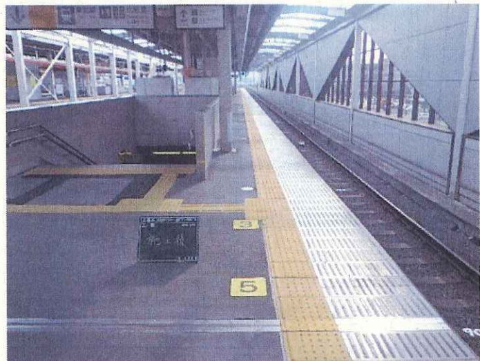
内方線付き点状ブロックを設置〔H30年度〕
