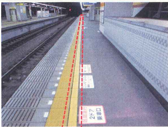
内方線設置（H29） （視覚障がい者などの転落防止策として、ホーム縁端の警告ブロックの内側に沿って一文字状の点字ブロックを設置し、ホーム内側が識別できるようにしたもの）
