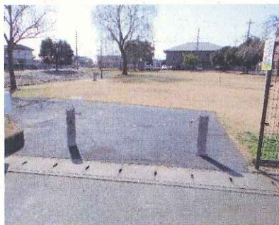
北側出入口 段差解消(H28年度)
