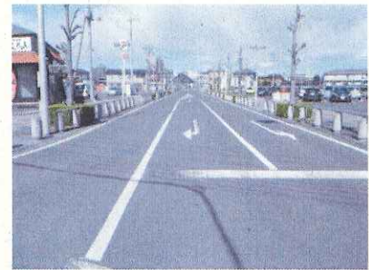
センターライン・路側線表示後 市道1041(104)号線②
