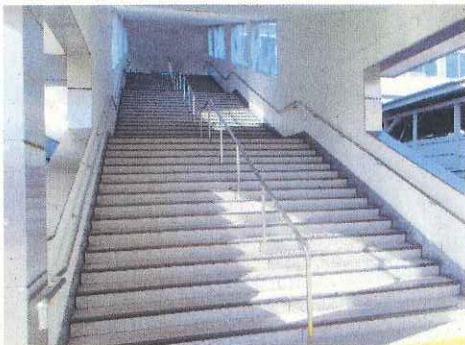
階段(西側・H26設置)
