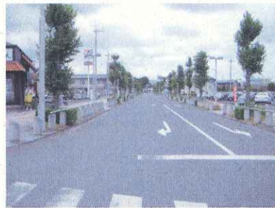
センターライン・路側線表示前
