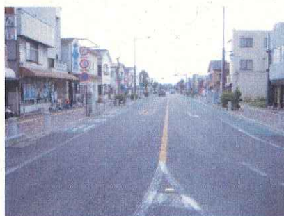
県道新栃木停車場線②
