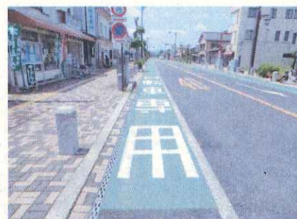
県道新栃木停車場線
