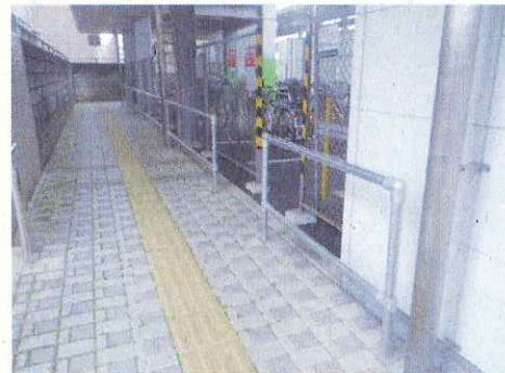
西側通路(H30設置)
