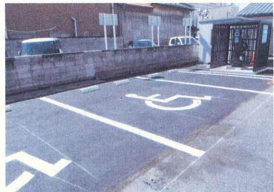
障がい者用駐車スペース
