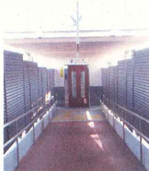
エレベーターの設置（H27）
