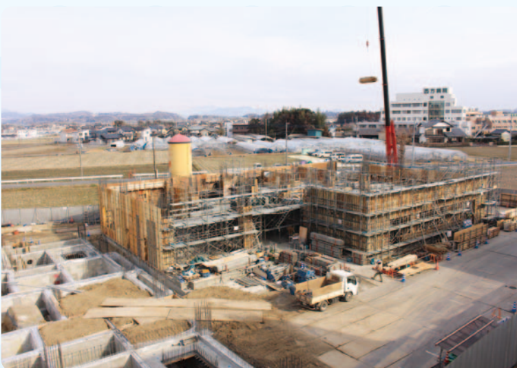
現在新築工事中の栃木市北部健康福祉センター(仮称)
