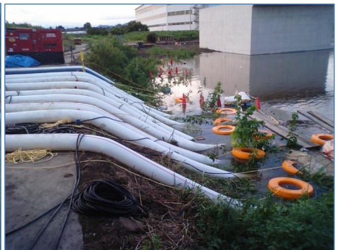
西前原排水機場内部
