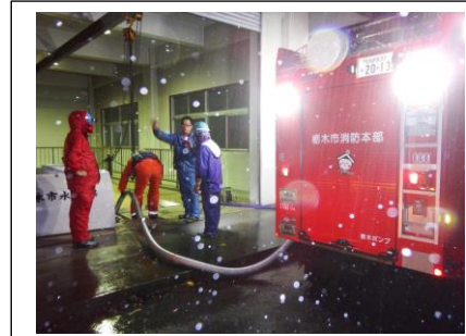
水道庁舎排水作業
