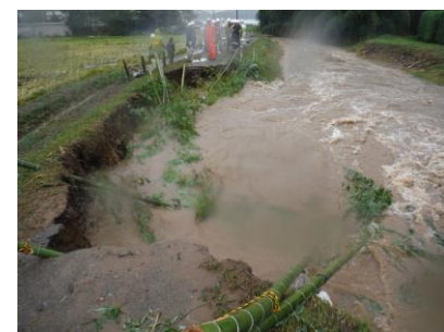
逆川洗堀に竹流し施工
