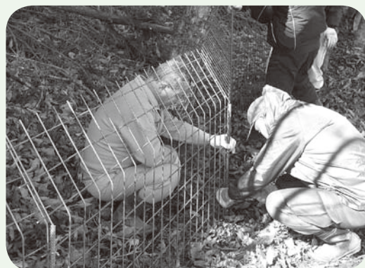
侵入防止柵設置の様子
