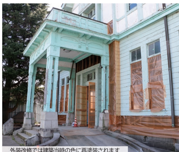
外装改修では建築当時の色に再塗装されます
