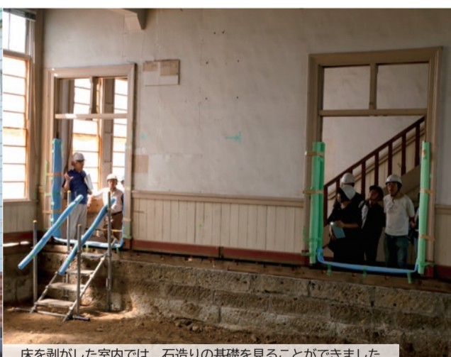
床を剥がした室内では、石造りの基礎を見ることができました
