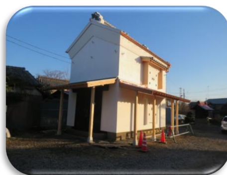
〔修理後の建造物〕
