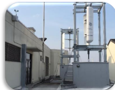
〔栃木市役所本庁舎屋上〕
