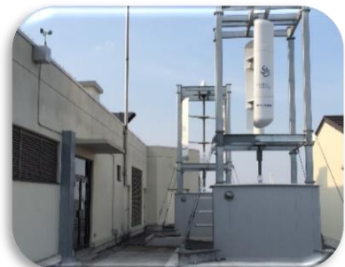
〔栃木市役所本庁舎屋上〕
