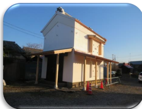
〔修理後の建造物〕
