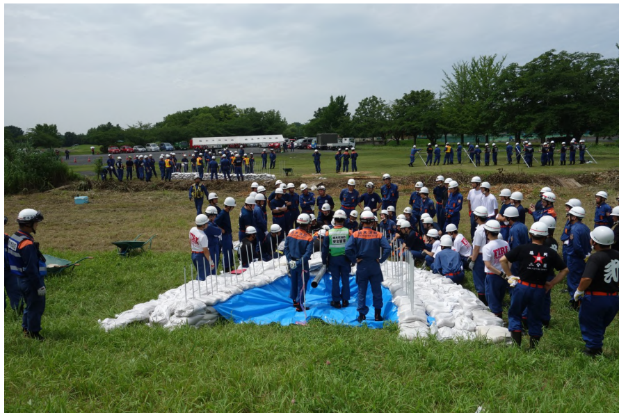
堤防からの漏水を抑える水防工法の一つ「月の輪工法」
