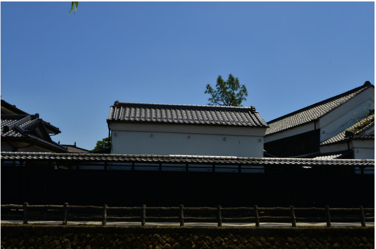
○旧米蔵と板塀（巴波川沿いより撮影）
