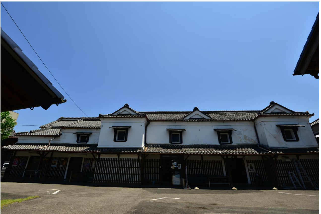
○白壁土蔵 1 と白壁土蔵 2（敷地内より撮影）
