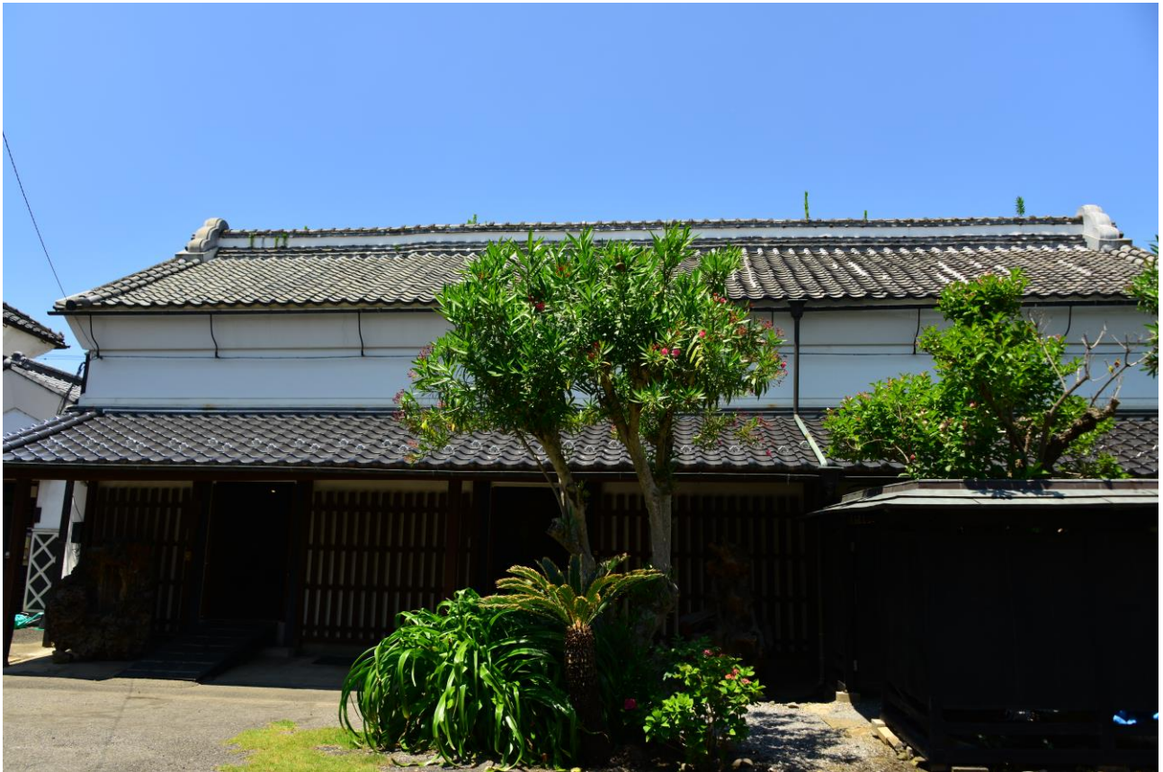
○旧収蔵蔵（敷地内より撮影）
