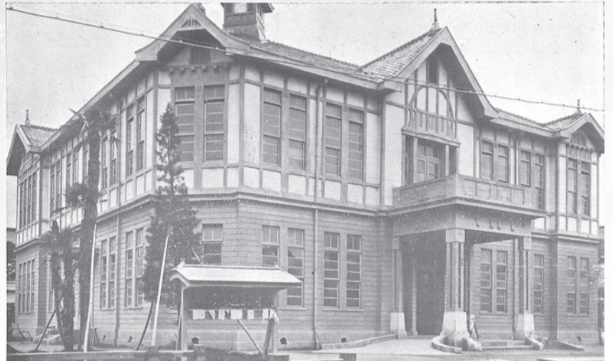
旧栃木町役場庁舎「昭和11年版 栃木町勢要覧」口絵より
