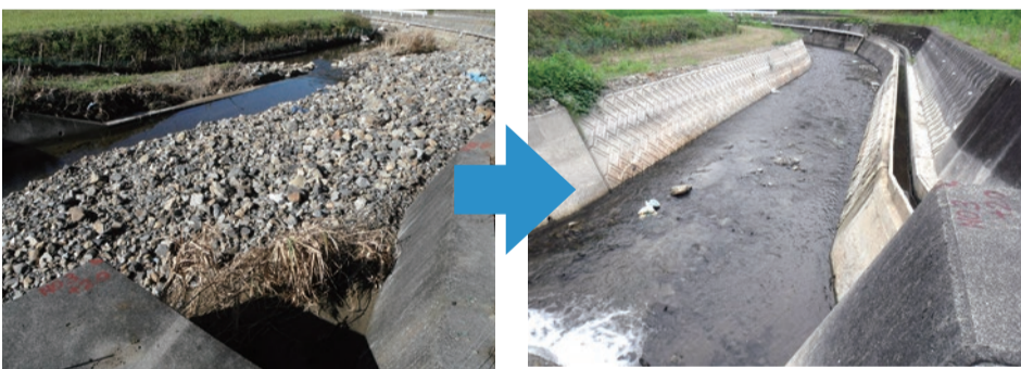
小野寺羽田川 復旧前(左)と復旧後(右)
