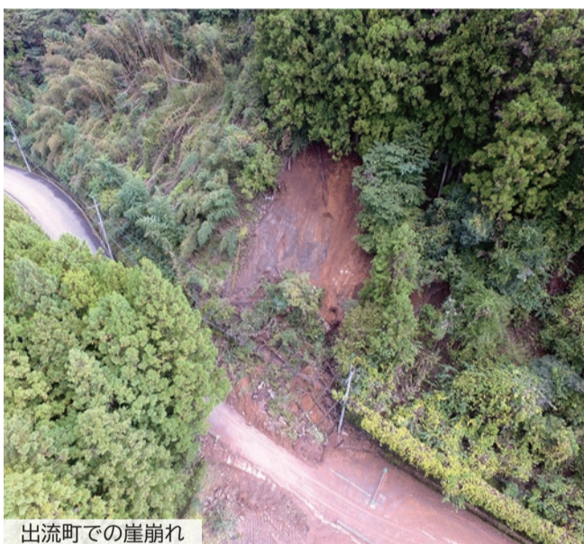
出流町での崖崩れ
