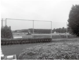
工事の進むサッカースタジアム建設現場
