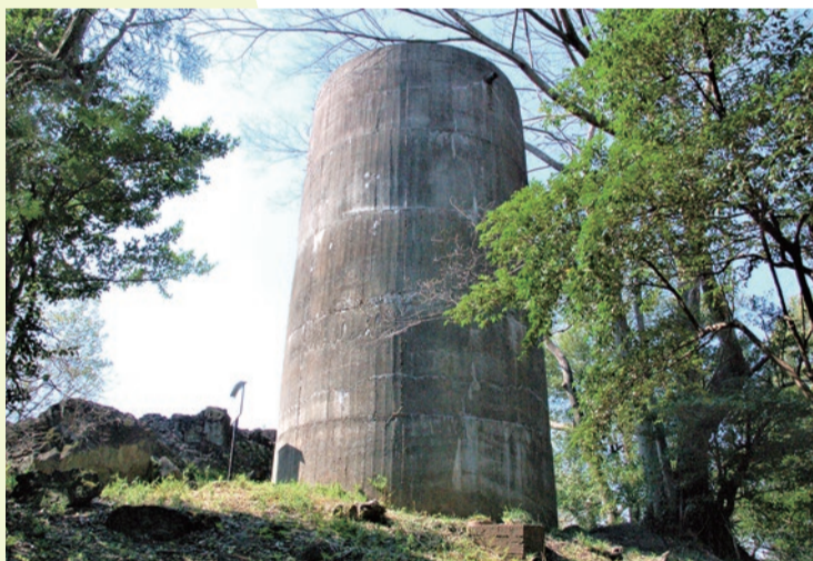
▲磯山頂上に残る巨大な水槽
