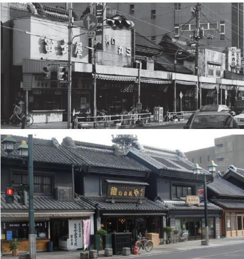
平成元年頃のアーケードがあった大通り(写真上とアーケードを撤去し、町並み修復事業を行った大通り(写真下))
