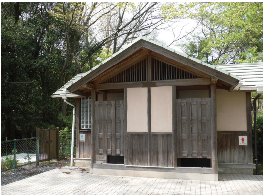
洋式化された岩船山公衆用トイレ
