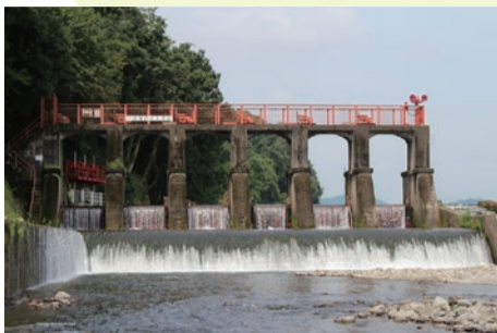
▲関東の三堰にも数えられている小倉堰
