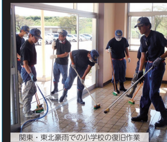
関東・東北豪雨での小学校の復旧作業
