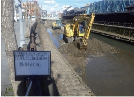
令和2年度は、出水期前に堆積土除去工事を行いました(湊町・令和2年5月撮影)
