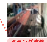
ベランダ改修
