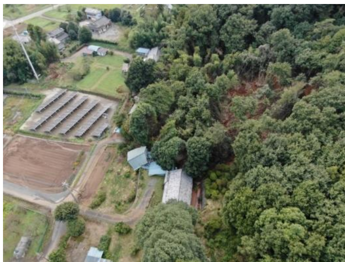
《岩舟町小野寺地内：土砂崩れ》
