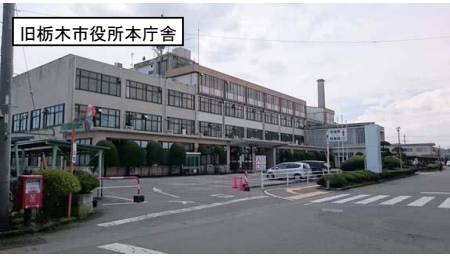
【①整備計画地(旧栃木市役所本庁舎)を北東側から眺める】 ※旧栃木市役所本庁舎は解体する
