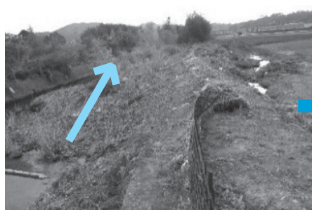
新小名路橋下2号(令和元年11月7日時点)
