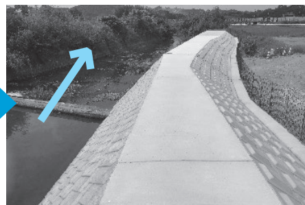
新小名路橋下2号(令和3年6月16日時点)
