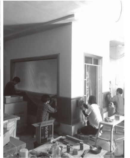
オープンに向けた改装作業
