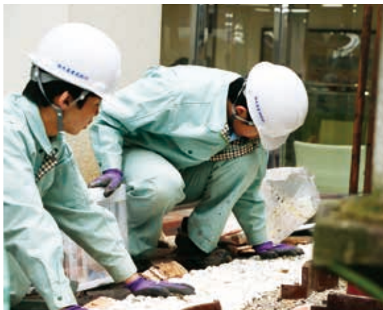
玉砂利を敷き詰めています
