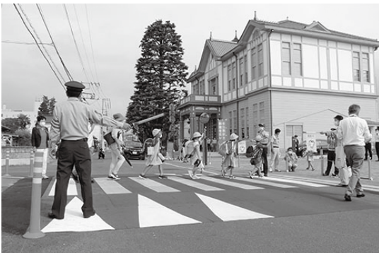
起伏を設けたスムーズ横断歩道の様子
