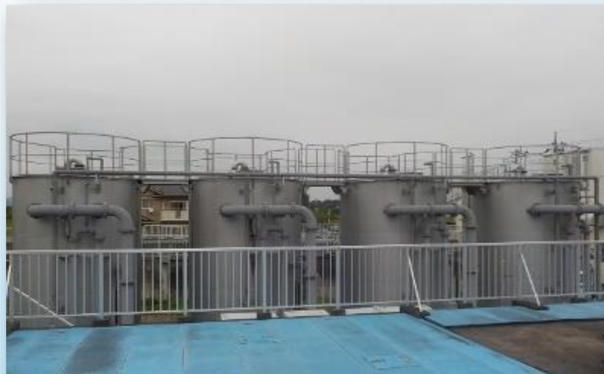
藤岡浄水場生物活性炭ろ過機
