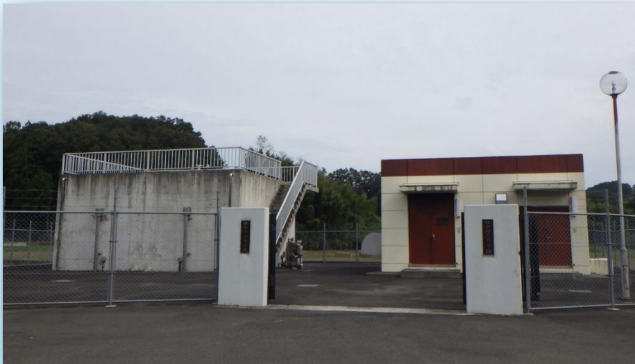
柏倉増圧ポンプ場
