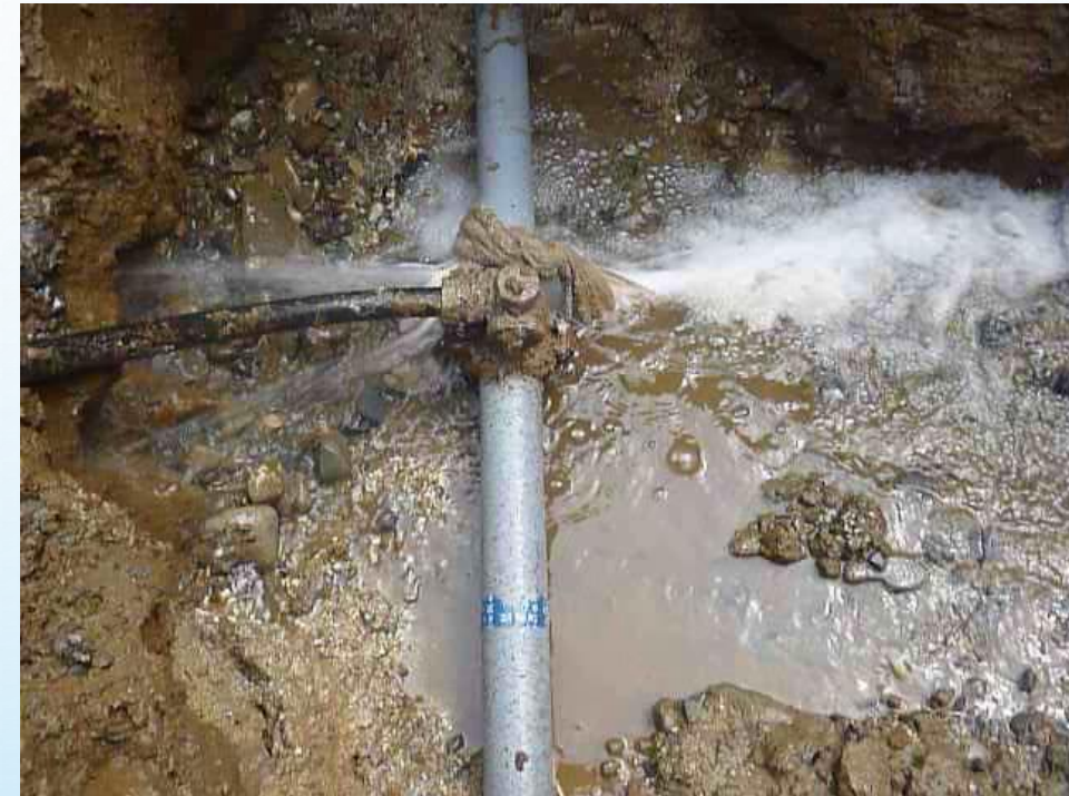
塩化ビニル管漏水状況
