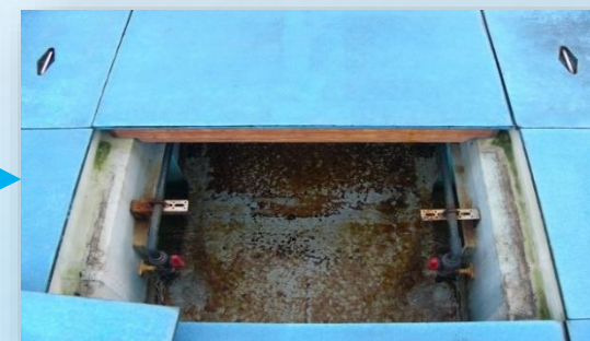
凝集沈殿処理完了
