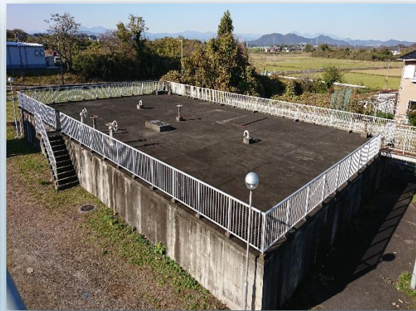
藤岡浄水場配水池 (RC造)
