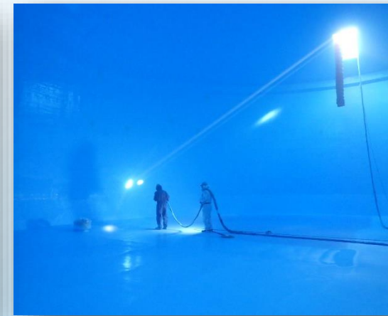
大塚浄水場配水池内部 (ポリウレア樹脂塗装)
