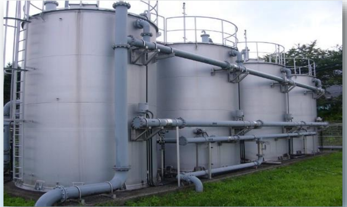
藤岡浄水場急速ろ過機
