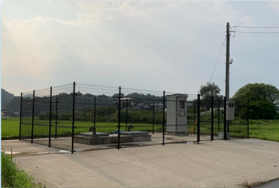
西方第7水源（深井戸）
