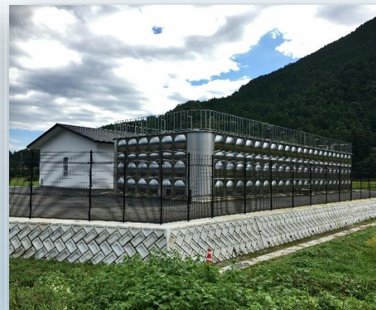
星野浄水場配水池 (SUSパネルタンク)
