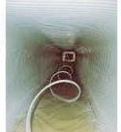
プラスチック材により既設管渠の内面を被覆
