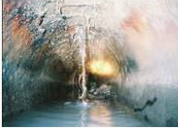
クラックからの浸入水
