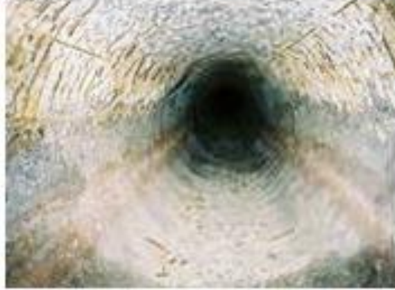
硫化水素による管路の腐食
