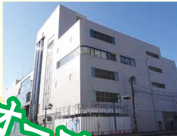
▲ 2 月 3 日から一部の業務開始予定の新庁舎
