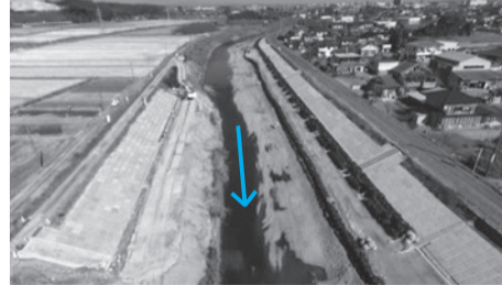
大平橋上流の施工状況（10月時点）
