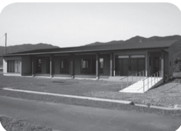
新たに整備した富田第七自治会公民館
