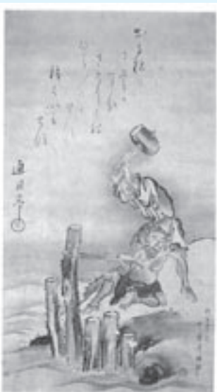
▲74年前の「美術日本」で紹介された「巴波川くい打ちの図」の写真
