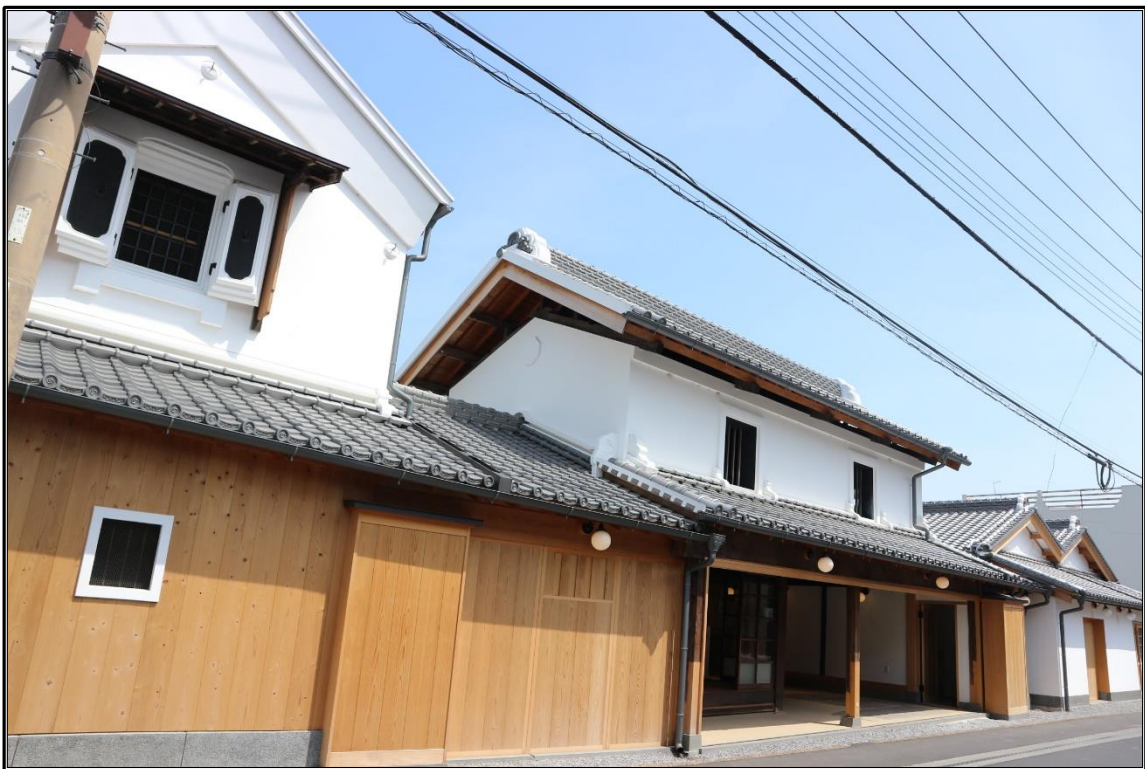
旧日光例幣使街道沿いの伝統的建造物（令和2年度修理）
